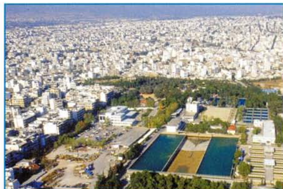
Η Μονάδα Επεξεργασίας Νερού της ΕΥΔΑΠ στο Γαλάτσι
